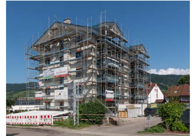
Innerhalb eines Jahres konnte der Rohbau für das neue Mehrfamilienwohnhaus an der Fernacher Höhe 7 a fertiggestellt werden.
